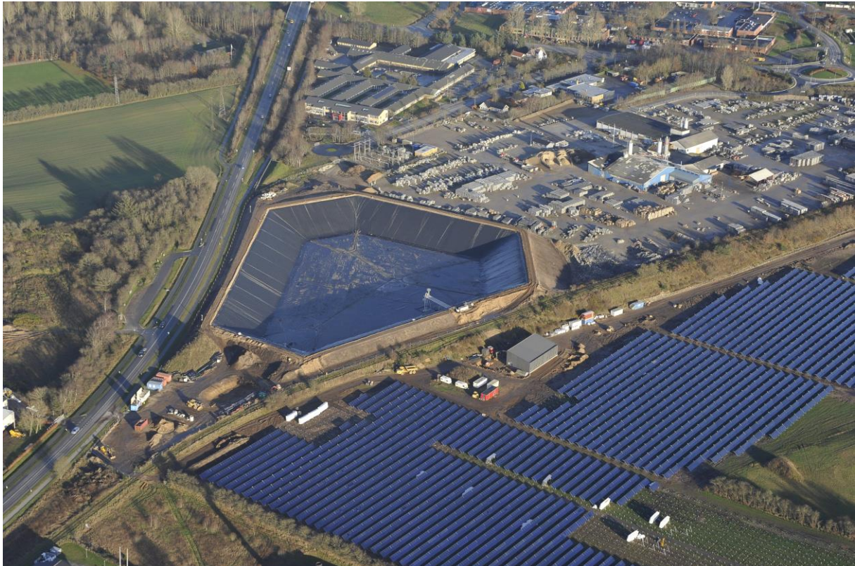
Abbildung 1: Bisher größter existierender Großwärmespeicher, ein wassergefüllter Erdbeckenspeicher mit einem Speichervolumen von etwa 200.000 m 3 , in Vojens, Dänemark. Bildquelle: Arcon-Sunmark.
